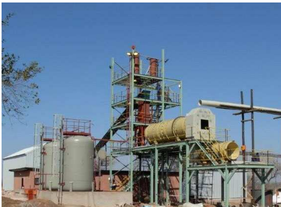
شکل ۶: تصویر یک واحد تولید کود سوپر فسفات در حال احداث
