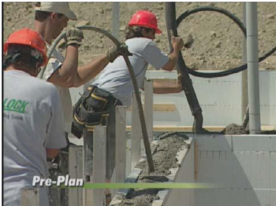
شکل (3) بتن ریزی در قالبهای ویژه ICF
