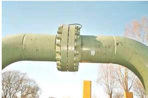
فلنجهایکی از اتصال دهنده‌های لوله‌ها، شیر آلات و دستگاهها به یکدیگر می‌باشد.
