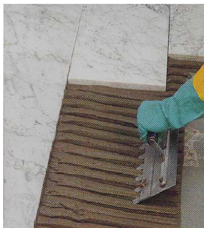
شکل ۲- جهت نصب کف-افقی
