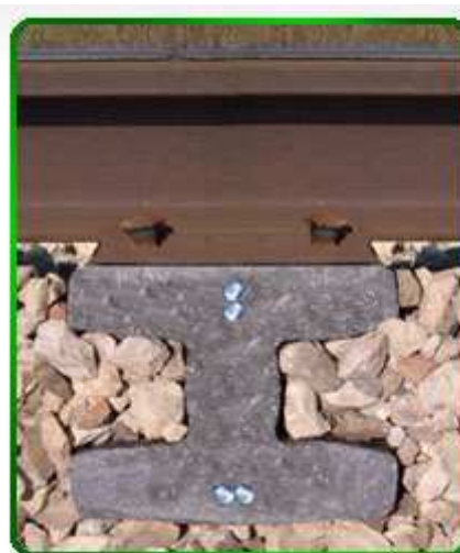
شکل (۳): تراورس کامپوزیتی ساخت شده شرکت PRT
