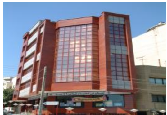
شکل ۱۰-۱- کاربرد ورق پلی کربنات در نمای ساختمان
