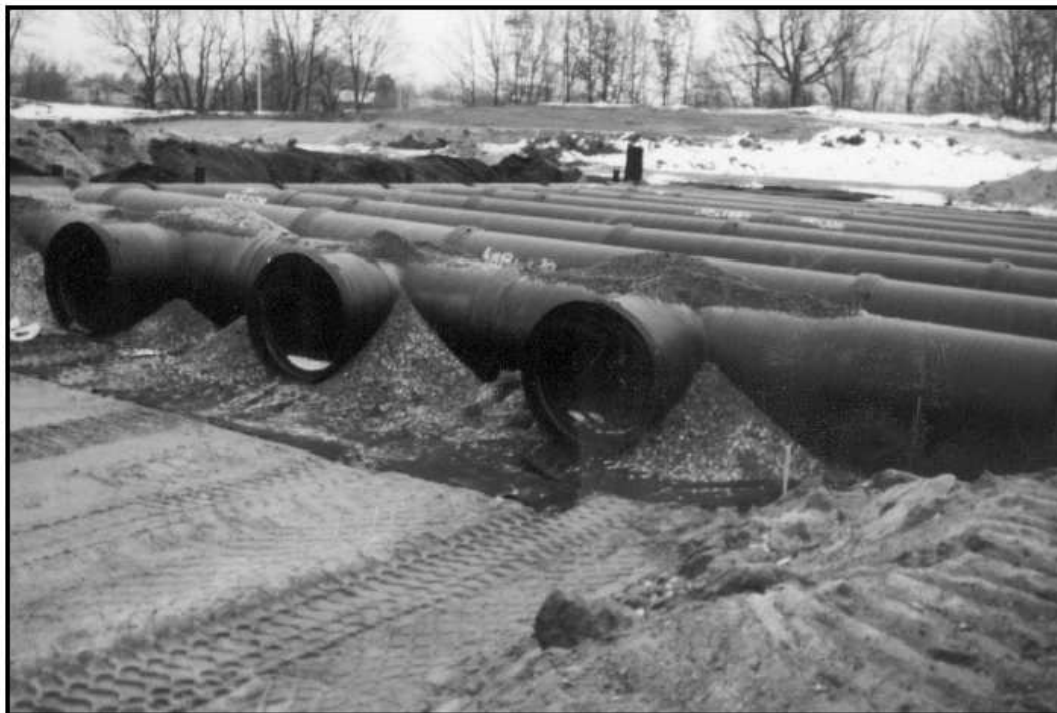
شکل (۸): کاربرد لوله‌های پلی اتیلن کروگیت در جمع‌آوری سیلاب
