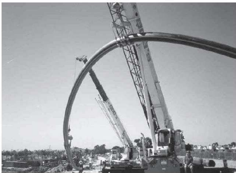
شکل (۲): انعطاف پذیری لوله های HDPE در حین نصب
