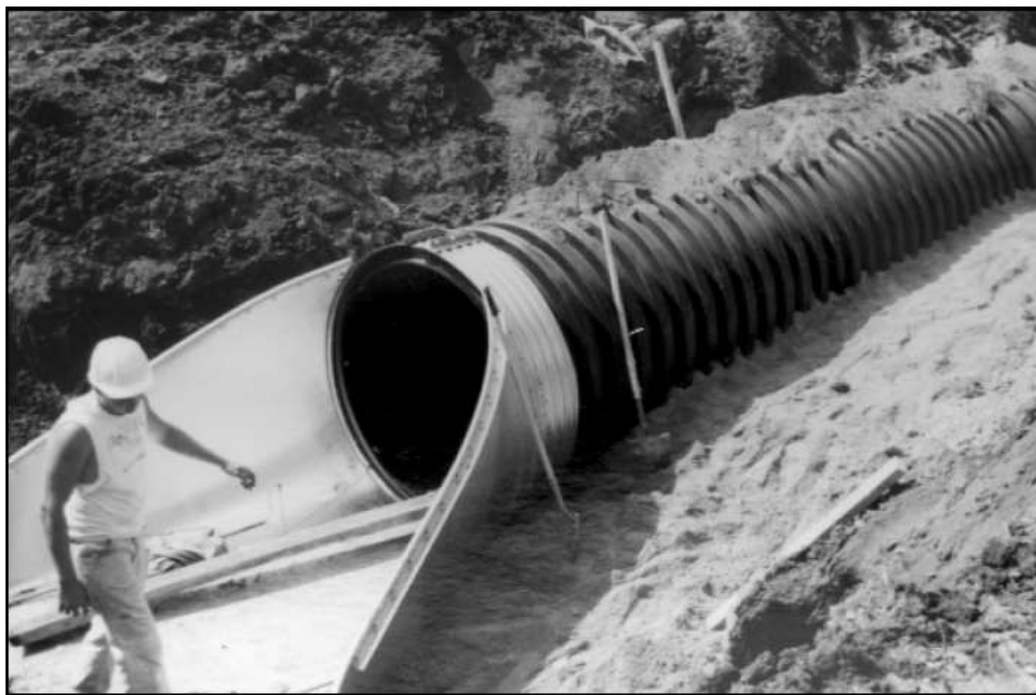
شکل (۷) : کاربرد لوله های پلی اتیلن کروگیت جهت هدایت آبهای زیر اتوبانها با زبانه ای کشیده در انتها
