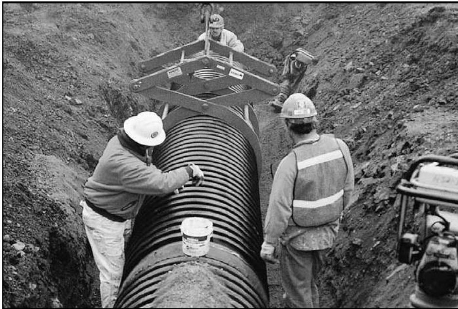
شکل (۶): اتصال لوله‌های کروگیت موجدار با استفاده از واشر جهت مصارف فاضلاب
