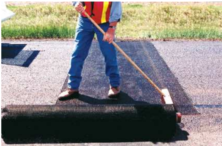
شکل (۲): کاربرد ژئوگرید در جاده سازی
