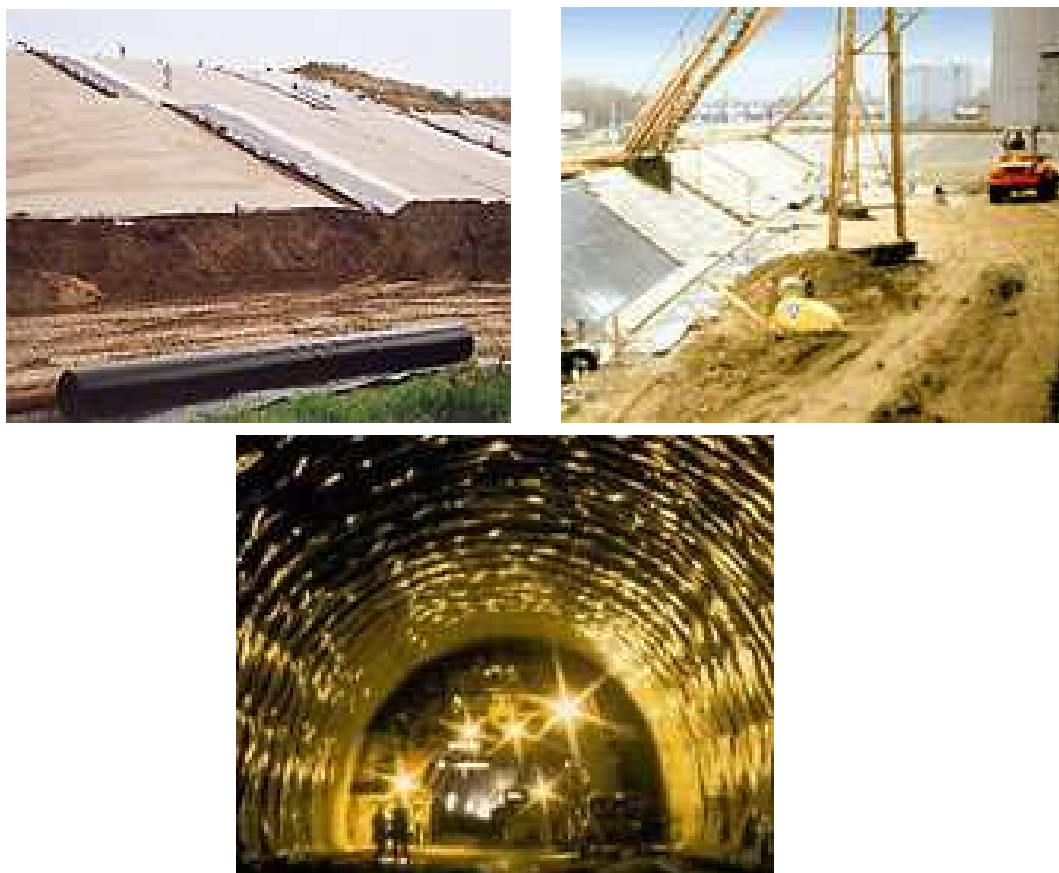
شکل (۹): کاربرد ژئوممبرین ها در ایزولاسیون
