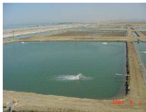
شکل (۱۰): کاربرد ژئوممبرین ها در ایجاد استخرهای آب
