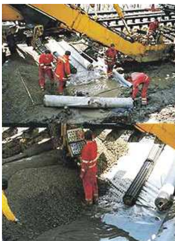
شکل (۱۲): کاربرد ژئوممبرین در معادن
