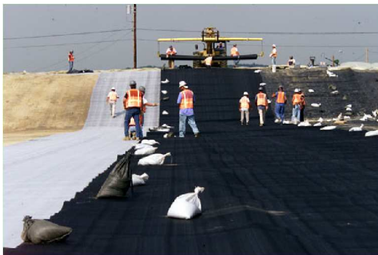
شکل (۱۵): اجرای عملیات نصب ژئوممبرین
