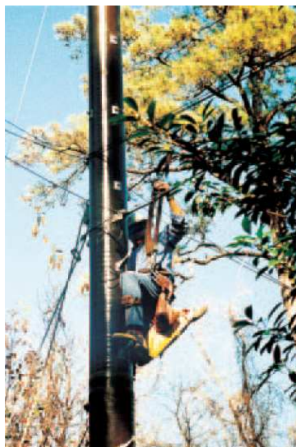
شکل ۸- دکل تلسکوپی کامپوزیتی استفاده شده در ایالت فلوریدا (آمریکا)
