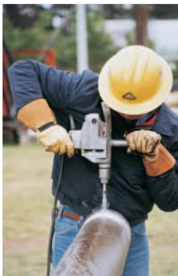
شکل ۴-سوراخ نمودن محل اتصال برای بازو های عرضی
