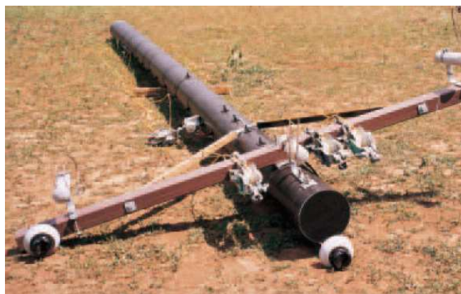
شکل ۵- نصب و پیچ نمودن بازو های عرضی
