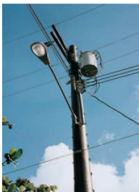
شکل ۷- استفاده دو منظوره از پایه دکل (روشنایی، انتقال برق)
