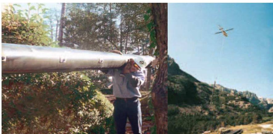
شکل ۶- حمل هوایی با هلیکوپتر کوچک به محل سایت در مناطق جنگلی (مونتانا) حمل و نقل آسان
