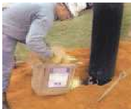
شکل ۱۳- ریختن مایع داخل ظرف درون گودال دور پایه بعد از ۱۵ دقیقه میتوانید تکیه گاه‌ها را برداشته و دور پایه را پاکیزه کنید
