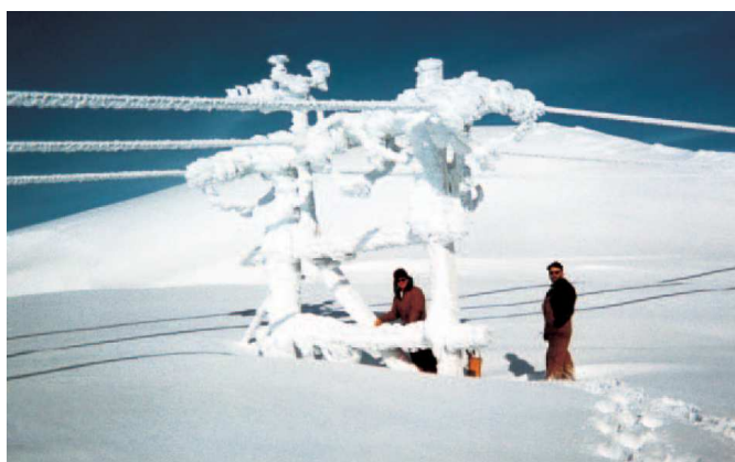
شکل ۱۰- توانایی کاربری دکل تلسکوپی کامپوزیتی در مناطق سردسیر آلاسکا با بیش از ۲۰ متر برف
