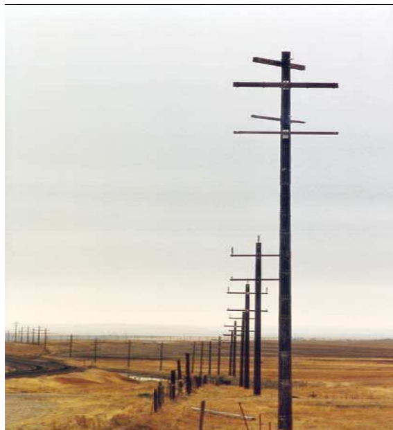
شکل (۲) بازوی عرضی‌های عرضی نصب شده روی دکل‌های انتقال نیرو
