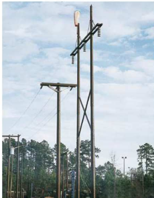
شکل (۷): نمونه ای از کاربری بازوی H Frame
