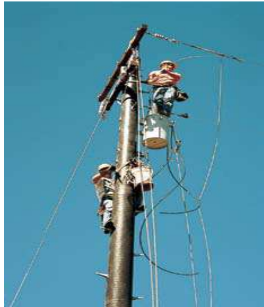
شکل (۴): بازوی عرضی کامپوزیتی در حال نصب بر روی دکل برق
