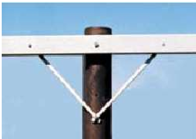
شکل (۱۱): استفاده از بازوی عرضی کامپوزیتی
