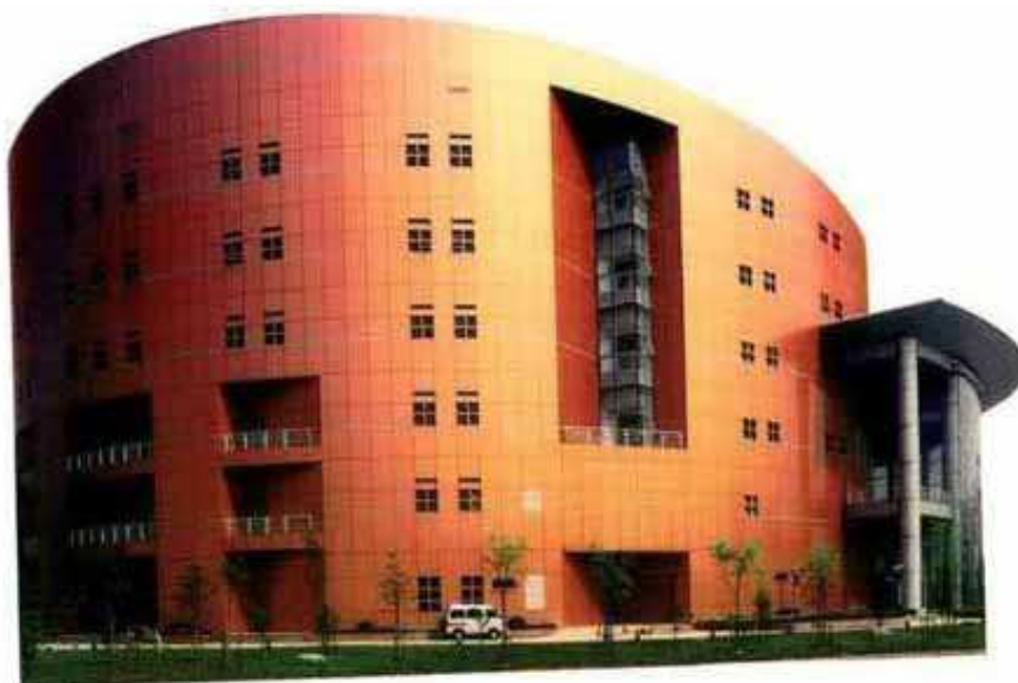
شکل (۴): انعطاف پذیری ورق کامپوزیت آلومینیومی
