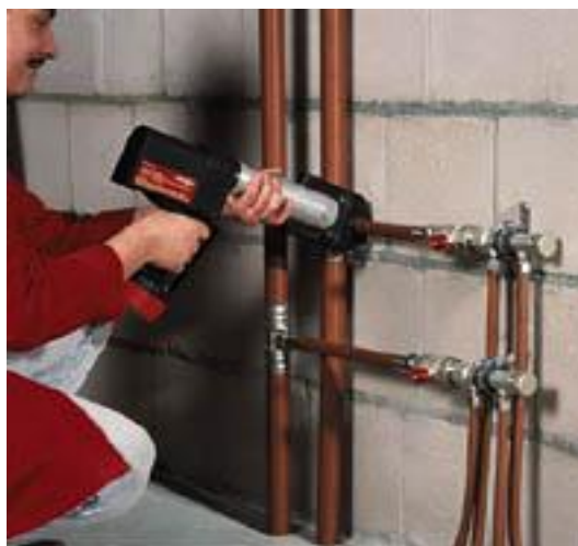
شکل ۱-۲- شمائی از نصب لوله های سوپر پایپ [۲]
