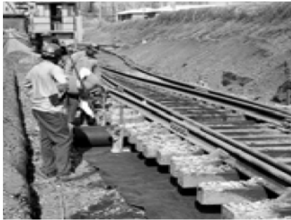
شکل (۱۰): نسب یک لایه ژئوتکستایل در زیرسازی ریل راه آهن.
