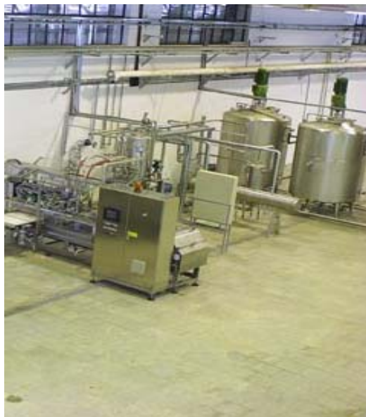
شکل ۲- مخازن ذخیره و سیستم شفاف سازی
