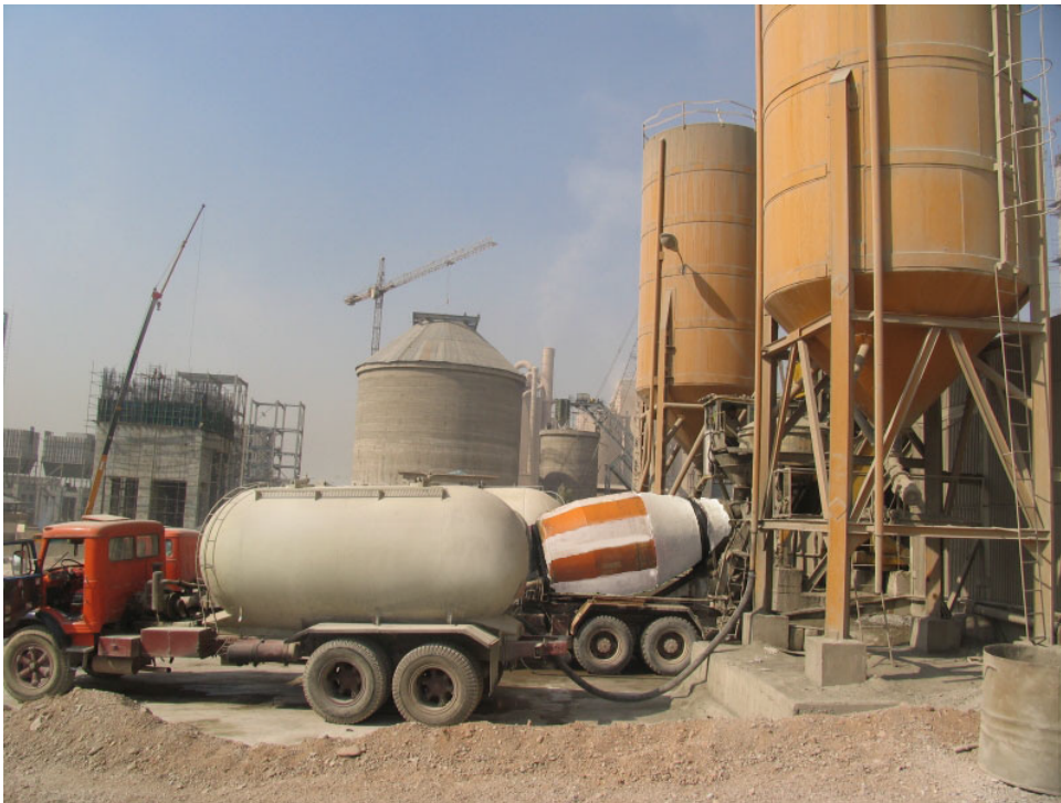
شکل ۳-۱: نمونه یک واحد تولید بتن آماده
